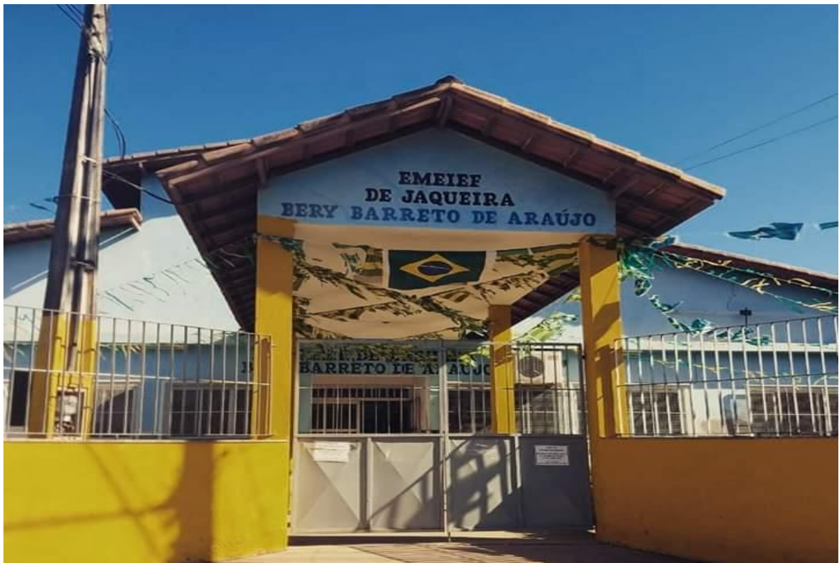
Fotografia 1 – Fachada da escola pesquisada
