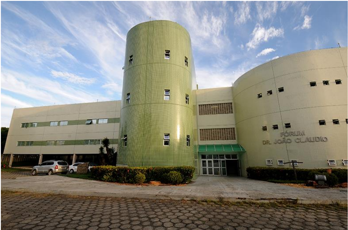
Figura 02 – Fachada do Fórum da Comarca de Colatina
