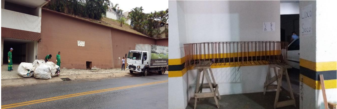
Figura 6: Fachada principal Ed. Flamboyant e Lixeira de resíduos recicláveis seco.
