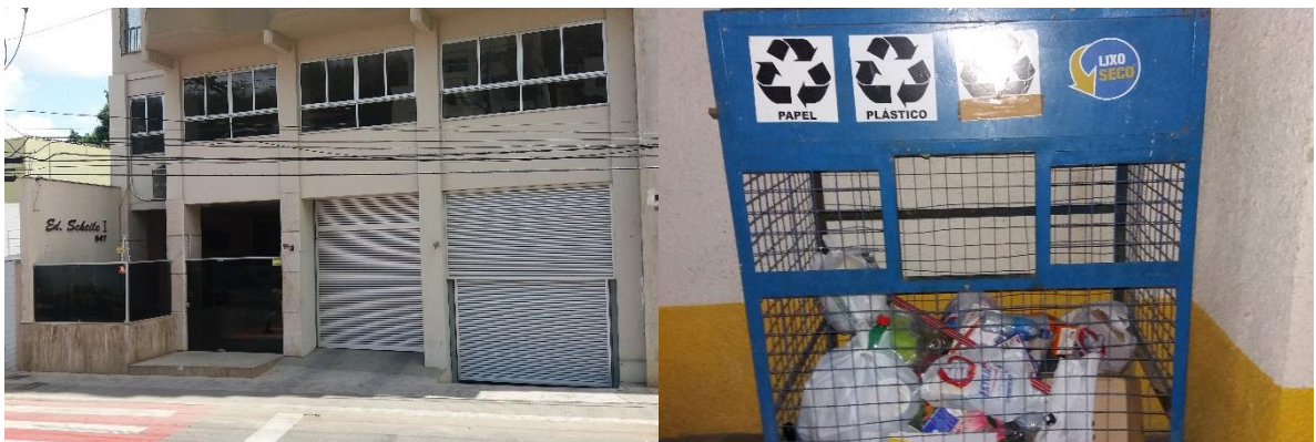
Figura 3: Fachada principal Ed. Scheile I e contêiner de resíduos recicláveis seco. Fonte: Autora
