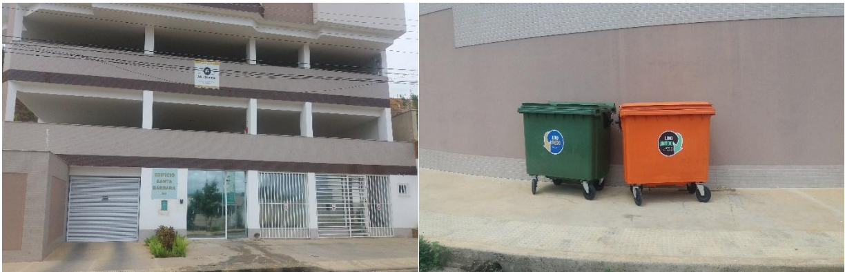
Figura 1: Fachada principal Ed. Santa Barbara e contêineres de resíduos.
