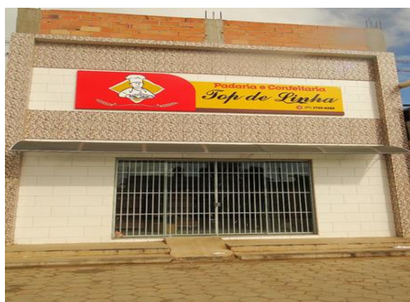
Ilustração 34: Fachada da nova padaria com melhor estrutura.
