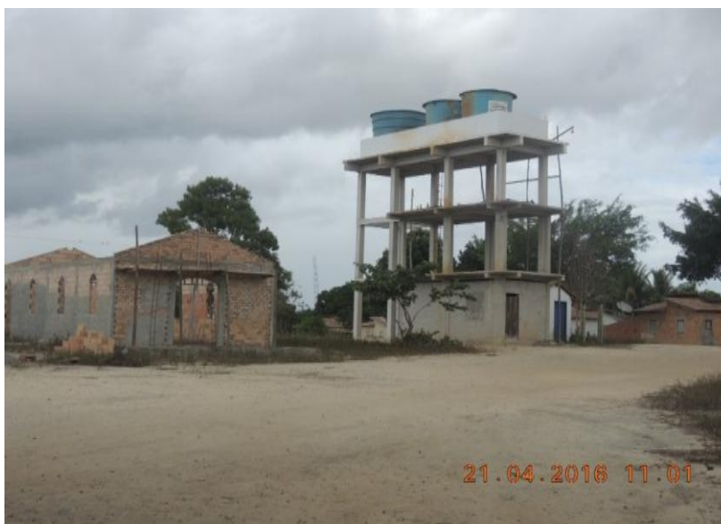
Figura 8: Vista parcial dos reservatórios abastecidos com a água do poço artesiano do assentamento Associação Terra Bahia. Fonte: Foto do Autor
