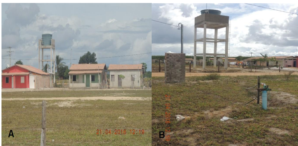
Figura 16: Vista dos dois reservatórios de água destinado ao abastecimento das residências da agrovila.
