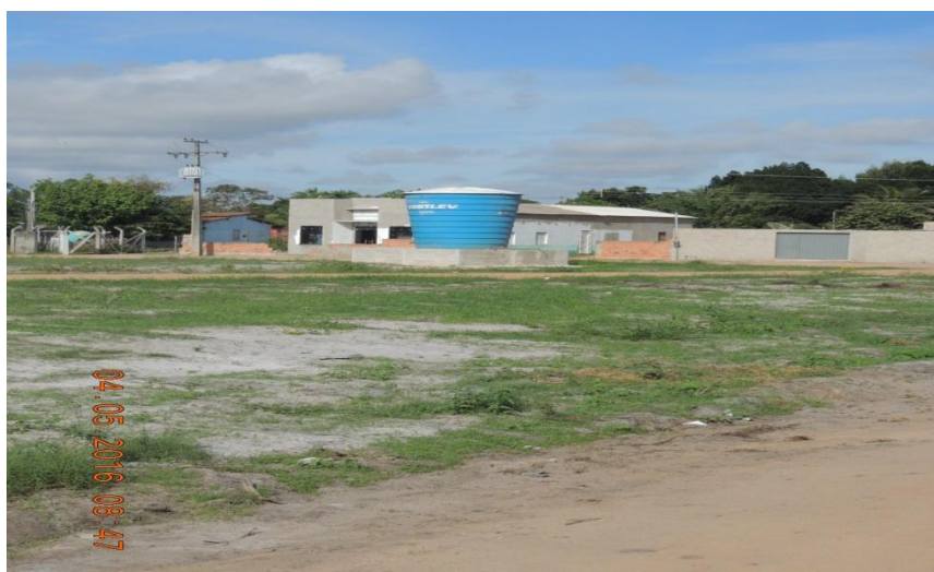
Figura 36: Identificando a existência de energia elétrica e o reservatório de água para abastecimento da agrovila. Fonte: Fotos do Autor
