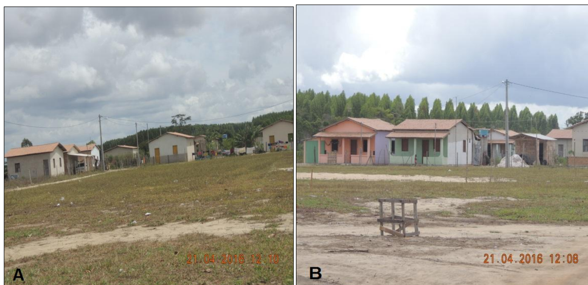
Figura 14: vista parcial das casas da Agrovila do Assentamento Santa Maria, mostrando casas com reboco parente e com pintura (A) e casa em fase de reforma e/ou ampliação (B). Fonte: Fotos do Autor
