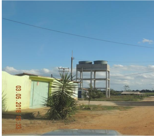
Figura 24: Foto castelo d'água do poço artesiano da agrovila do Assentamento Projeto Maravilha Fonte: Foto do Autor
