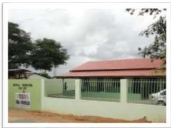
Figura 43: Fachada da EPM “Km 20”
