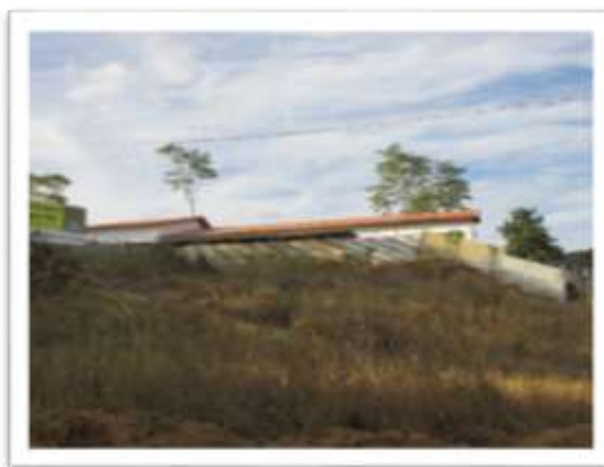
Figura 60: Vista da construção do novo Prédio da Escola
