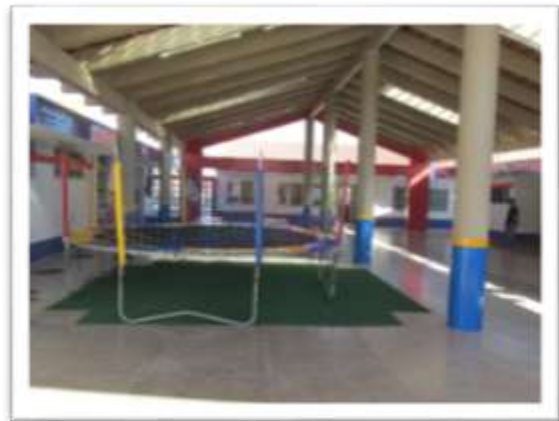
Figura 02: Refeitório e Área de Circulação
