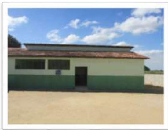
Figura 37: Fachada da EPM “Militino Carrafa”
