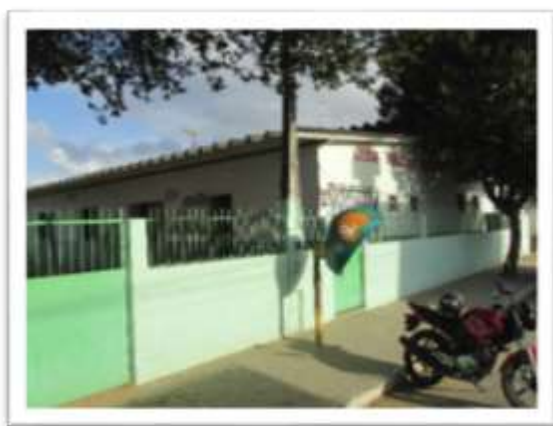
Figura 07: Fachada do CEIM Paraíso Infantil
