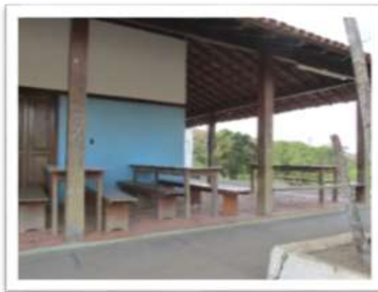
Figura 56: Refeitório e Área de Circulação
