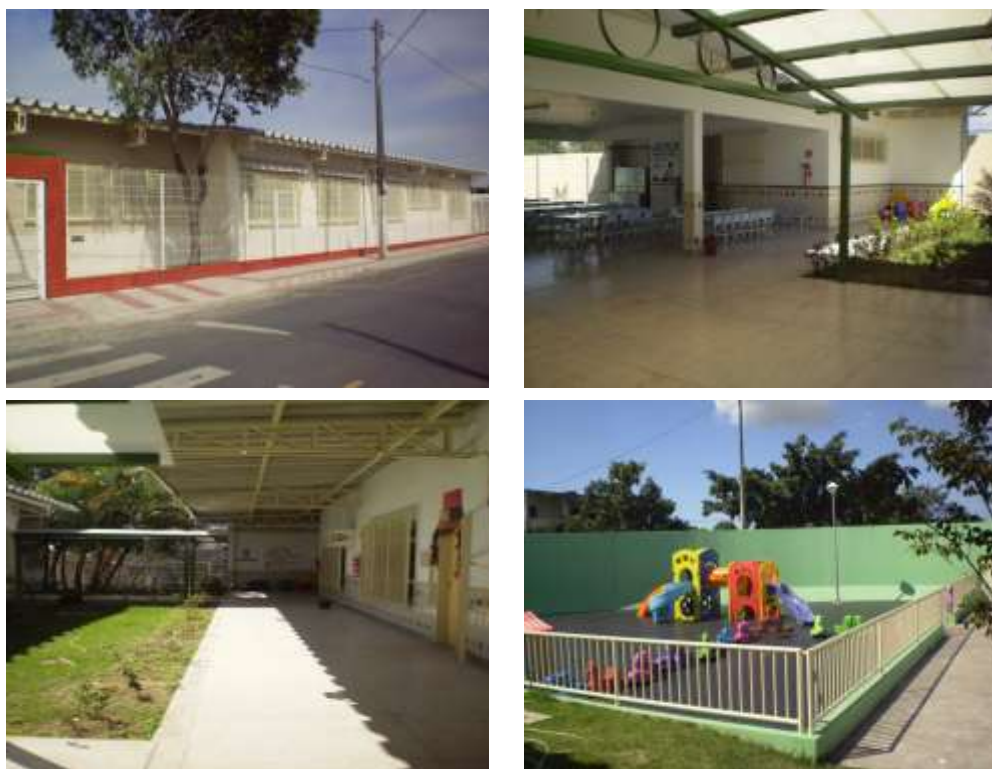
Figura 14 – Imagens do espaço reformado e ampliado do CMEI “Infância” Fonte: GAVA, 2014
