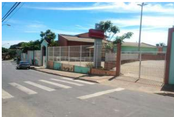
Figura 02 – Foto atual do CMEI que funcionava em uma casa adaptada Fonte: GAVA, 2014
