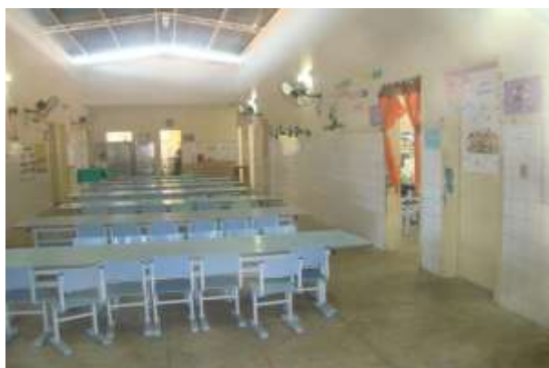
Figura 03 – Espaço interno do CMEI “Infância” antes da reforma Fonte: Arquivo do CMEI
