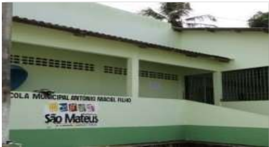
Figura 6: Fachada da escola Antônio Maciel em 09/11/2016 A Escola Pluridocente Municipal “Antônio Maciel Filho”, está situada no bairro Jambreiro, às margens do rio Cricaré, atendendo a uma comunidade ribeirinha.
