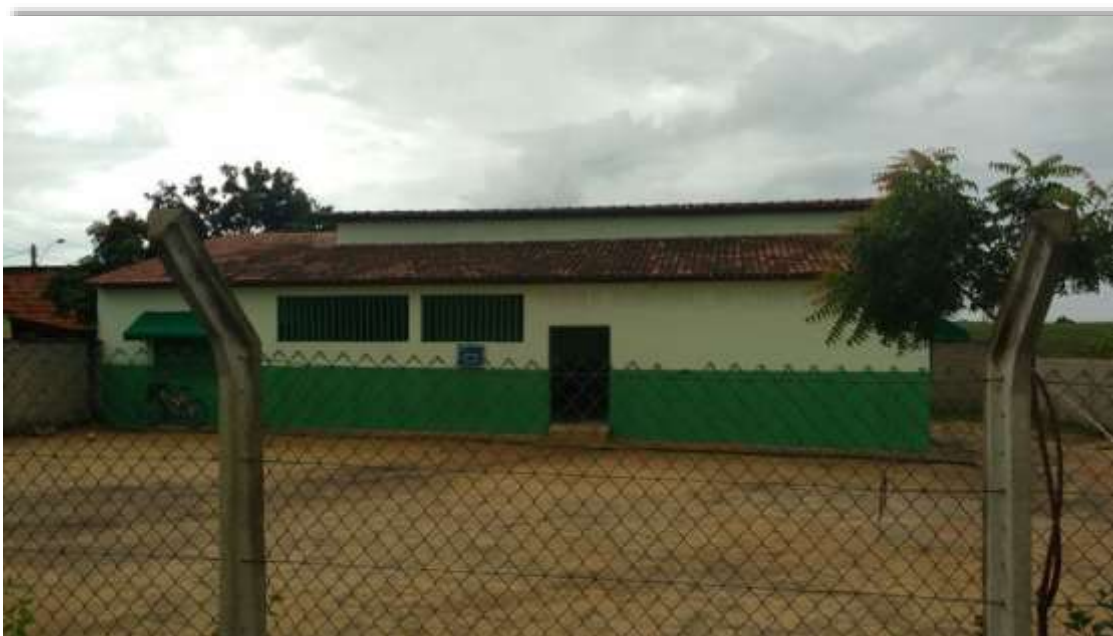
Figura 4: Fachada da escola EPM Militino Carrafa em 07/11/2016 Tendo sua localização no km 13 da BR 381 (Rod. Miguel Curry Carneiro), a Escola Pluridocente Municipal “Militino Carrafa” atende a uma comunidade denominada quilombola.
