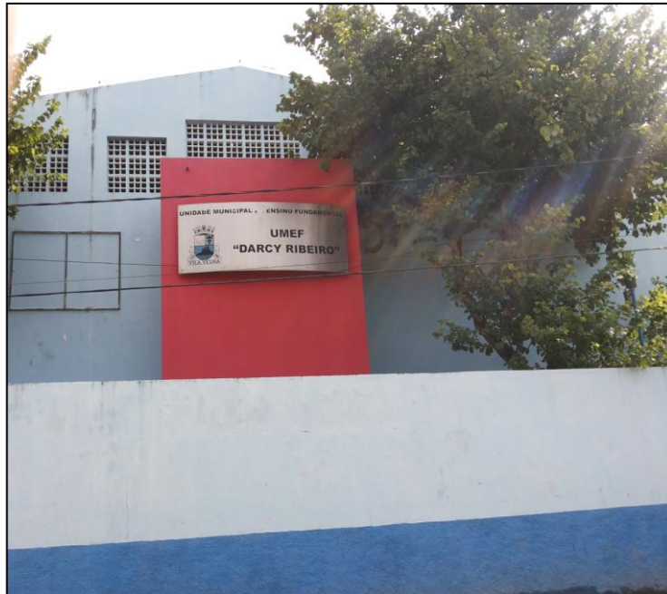
Figura 3: Fachada principal - UMEF Darcy Ribeiro
