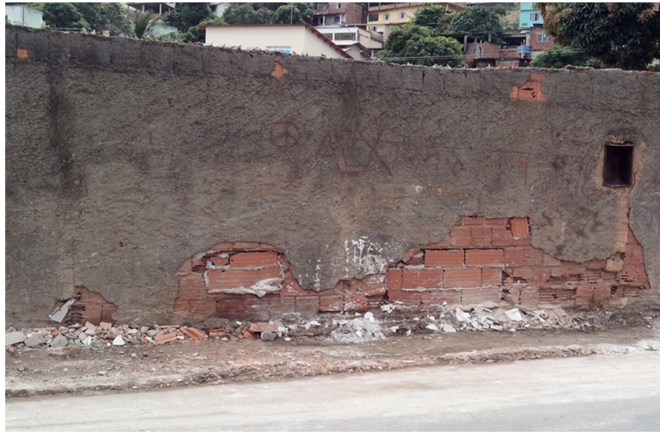
Figura 14 - Fotografia de local de deposição irregular de lixo Fonte: Do autor - Rua Prof. a Anízia Correia Rocha, Consolação (Após limpeza)
