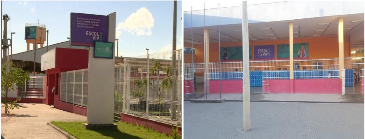
Figura 1 – Fachada do prédio da escola e pátio interno
