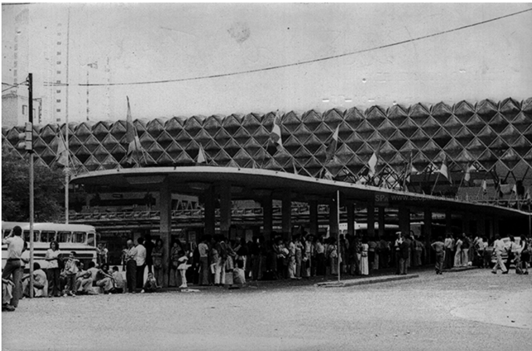
Figura 11 – Terminal Rodoviário da Luz, Déc. De 70
