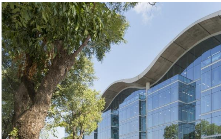
Figura 21: Fachada envidraçada da Prefeitura de Buenos Aires mostrando a cobertura ondulante.
