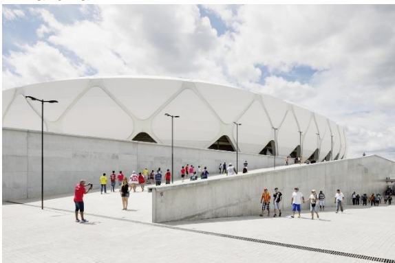
Figura 21: Fachada Principal – Arena da Amazônia
