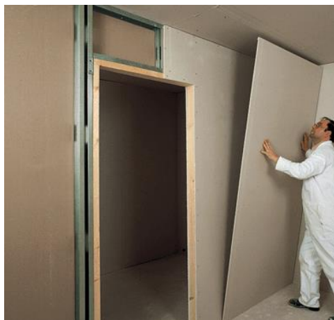
Figura 68: Instalação de chapas de gesso em parede de Dry Wall
