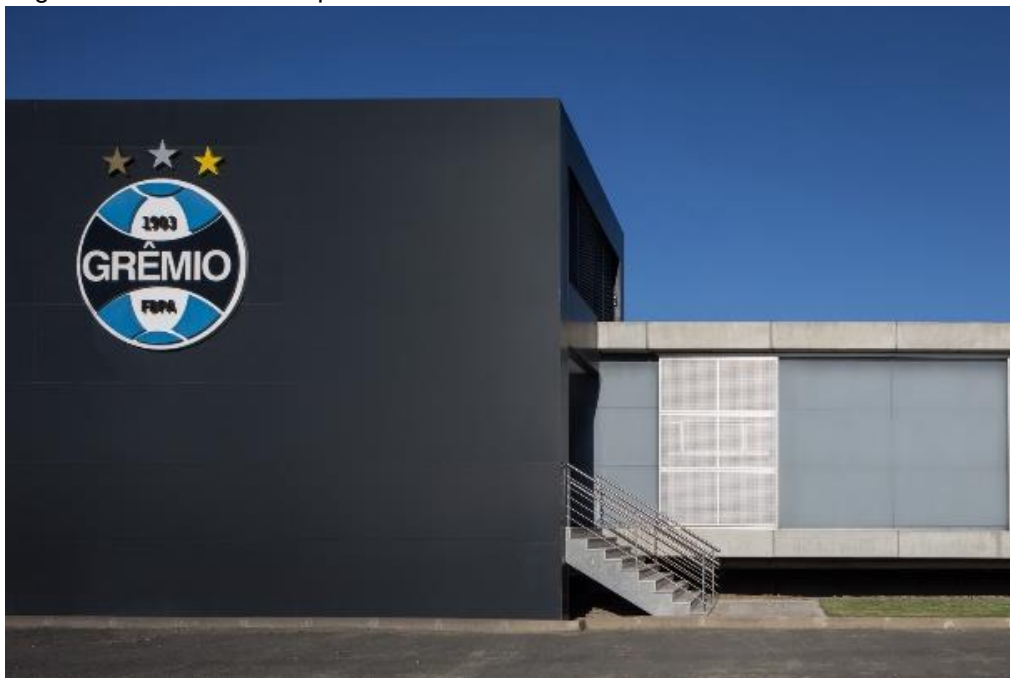
Figura 36: Fachada Principal - Centro de Treinamento do Grêmio
