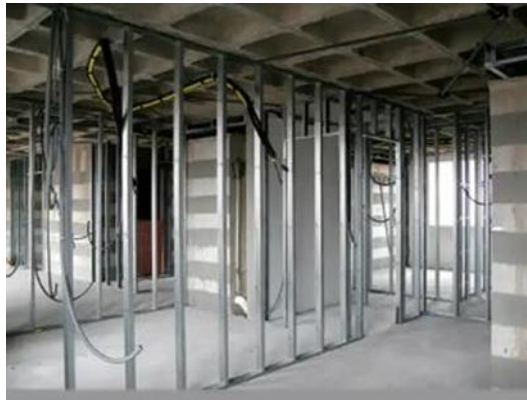
Figura 67: Esquema de uma parede em DryWall
