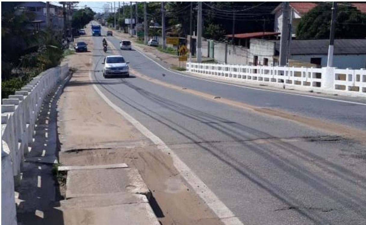
Figura 49 Imagem da Ponte sobre o Rio Mariricu, saindo do Bairro Guriri com sentido ao Centro de São Mateus.
