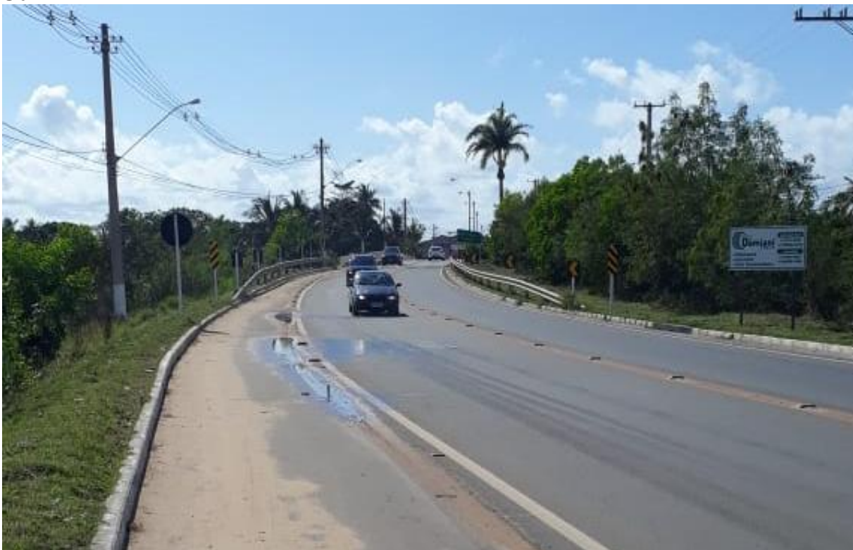
Figura 48: Imagem do acesso à ponte sobre o Rio Mariricu, sentido centro do Bairro Guriri.
