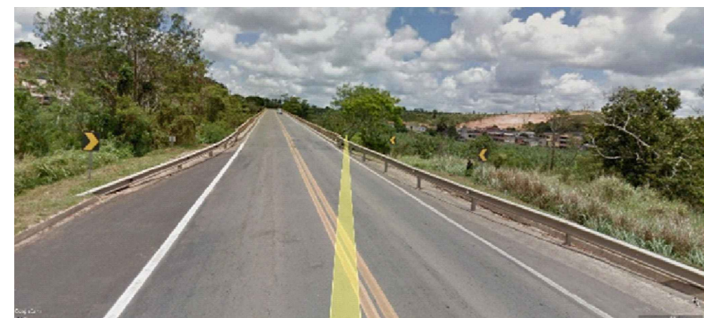
Ponte sobre o Rio Cricaré sentido bairro Litorâneo centro de São Mateus. O trajeto da ponte não oferece espaço adequado para travessia de pedestres ou ciclistas dentro da sua extensão de 200 metros
