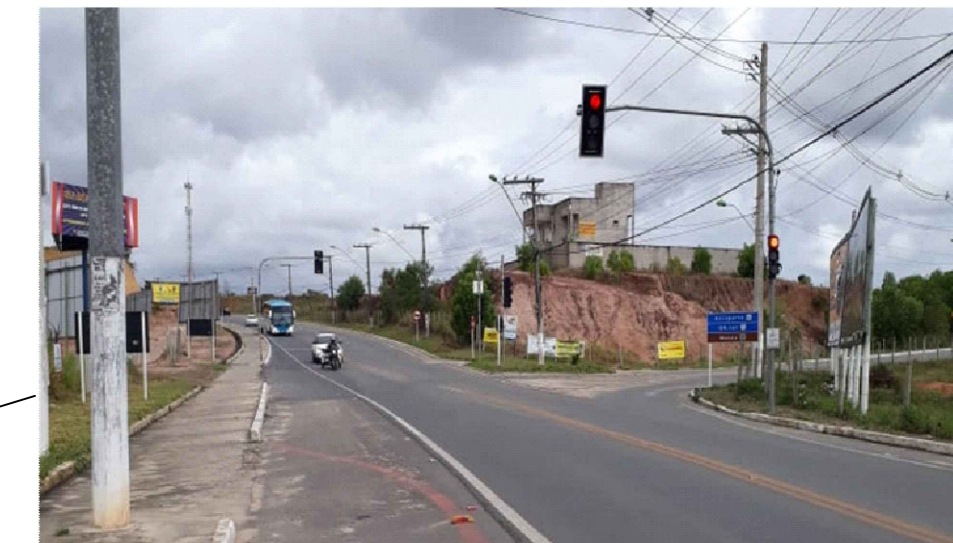
Cruzamento da Rodovia Otovarino Duarte Santos com a Rua Cel. Constantino Cunha no Bairro Pedra D'água
