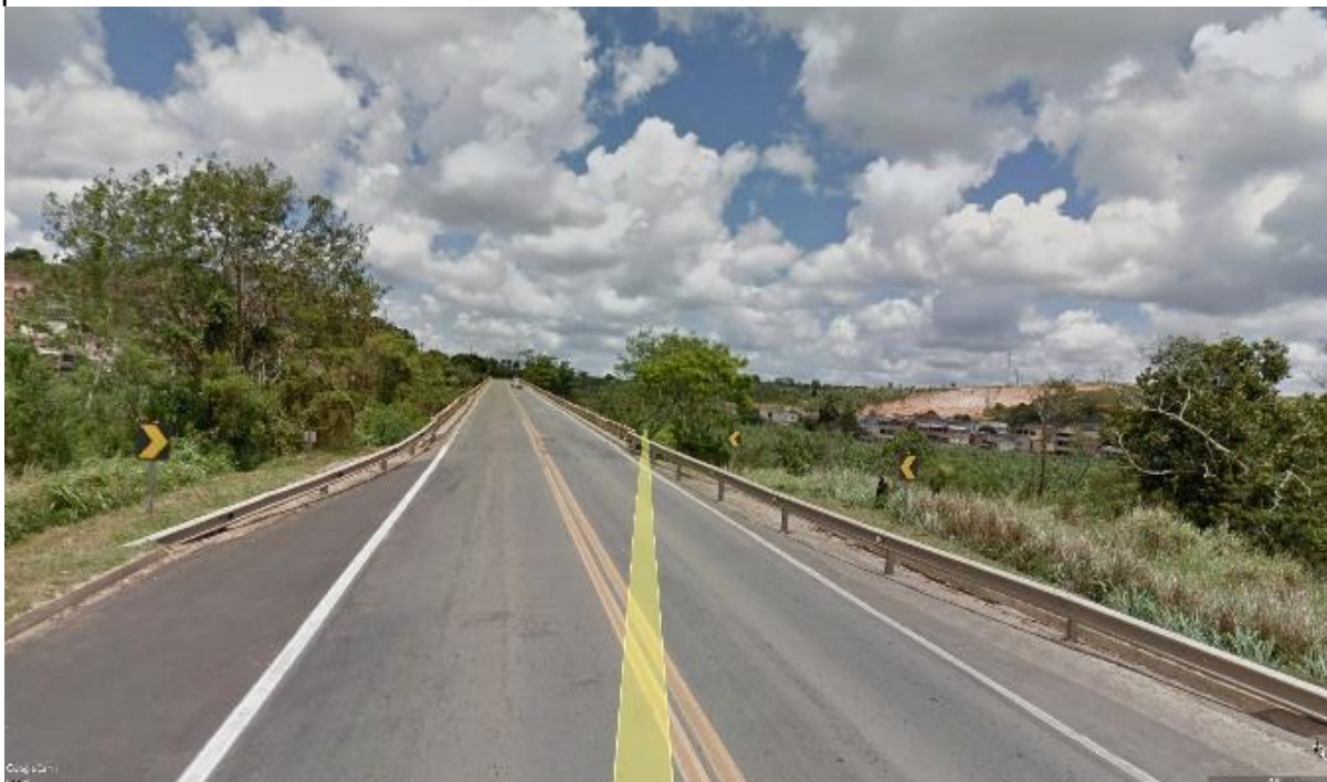
Figura 31: Imagem da ponte sobre o Rio Cricaré sentido bairro Litorâneo centro de São Mateus. O trajeto da ponte não oferece espaço adequado para travessia de pedestres ou ciclistas dentro da sua extensão de 200 metros.
