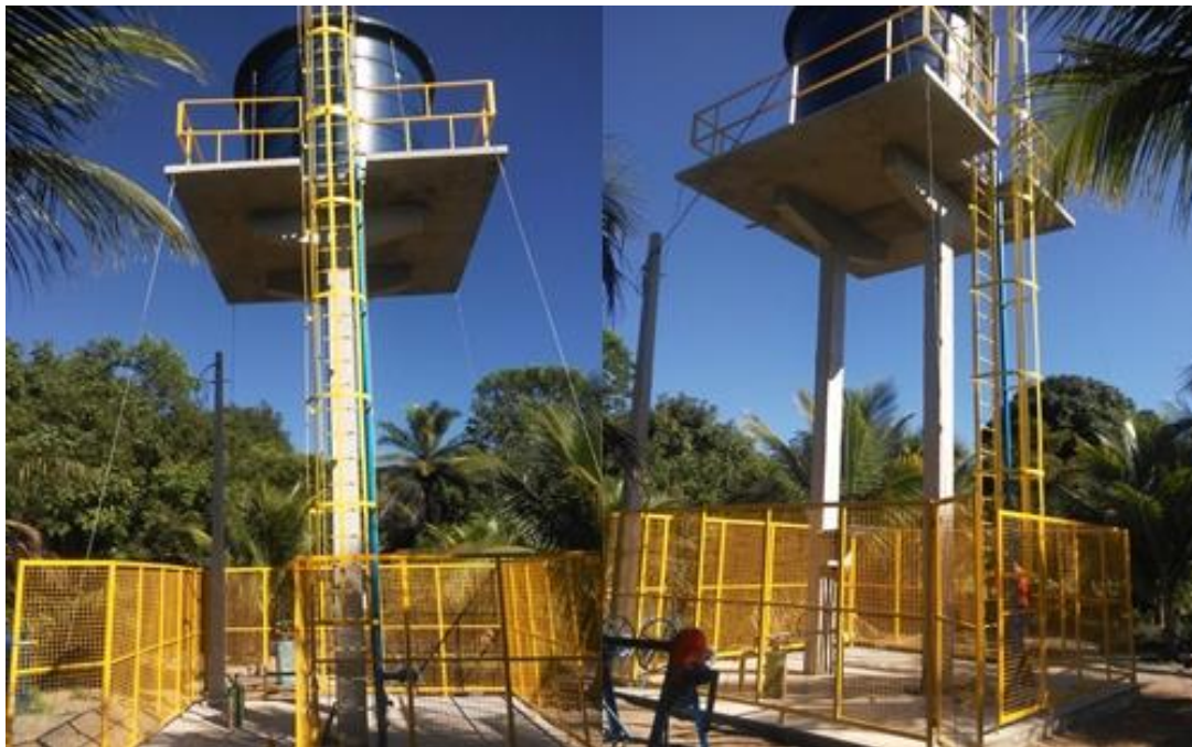
Figura 12: Estrutura de distribuição de água, já conectada ao poço artesiano.
