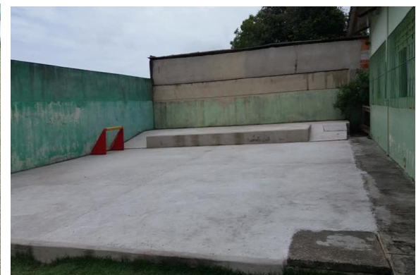
Área pavimentada (recentemente finalizada)
