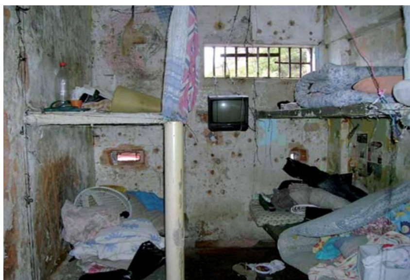
Figura 3: Casa de Passagem, demolida por impossibilidade de uso ou recuperação
