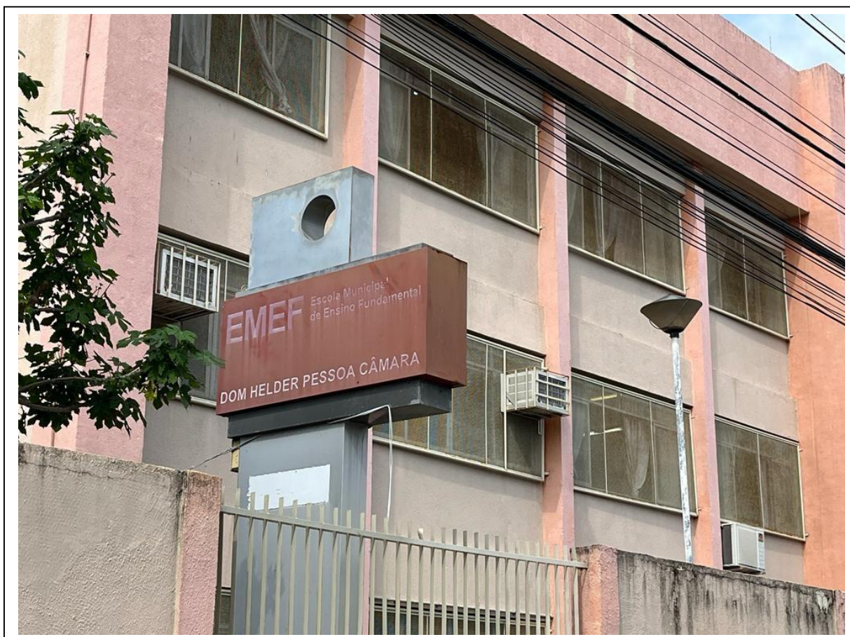
Figura 3 – A fachada da escola
