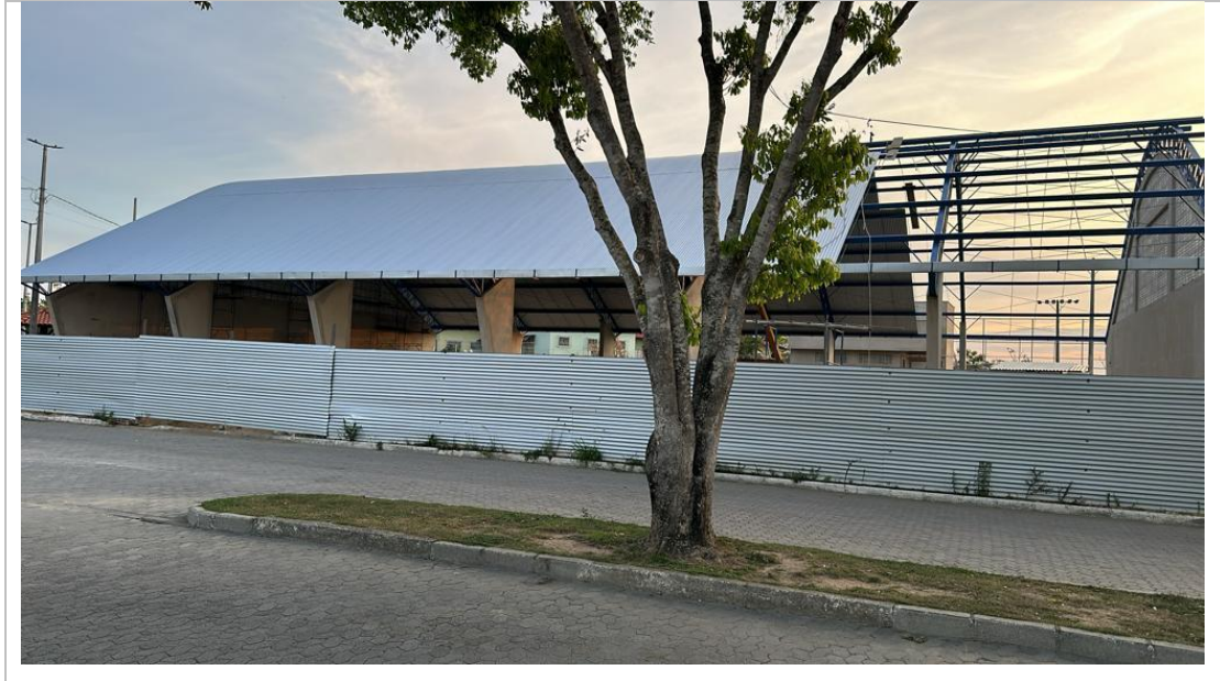
Imagem 26: Construção da Quadra Poliesportiva (Construída no espaço do antigo prédio da escola, ao lado do novo prédio 21/10/2023).
