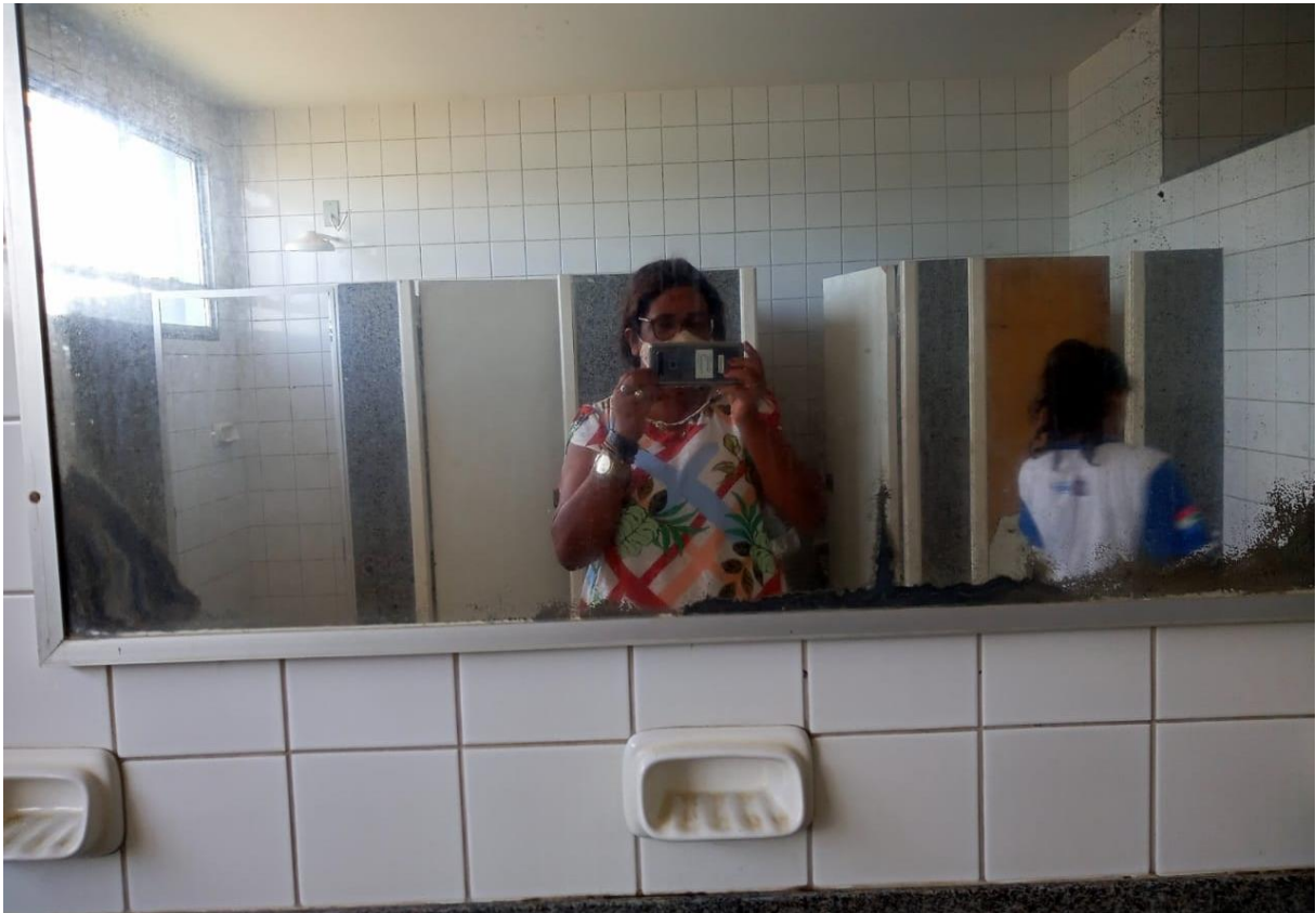
Figura 8: Depredação em banheiro
