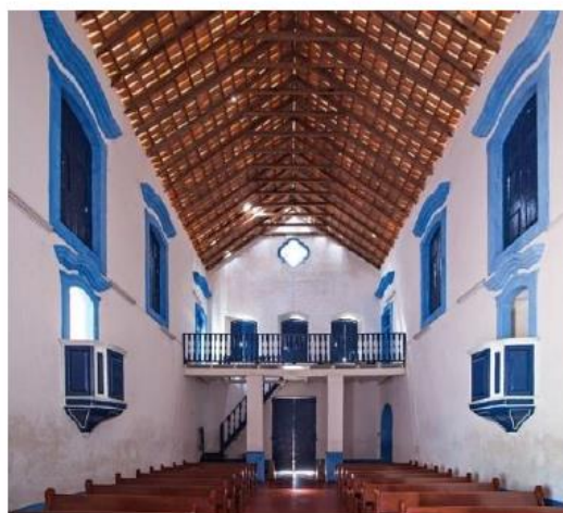
Figura 10 – Parte interna da Igreja de Nossa Senhora das Neves
