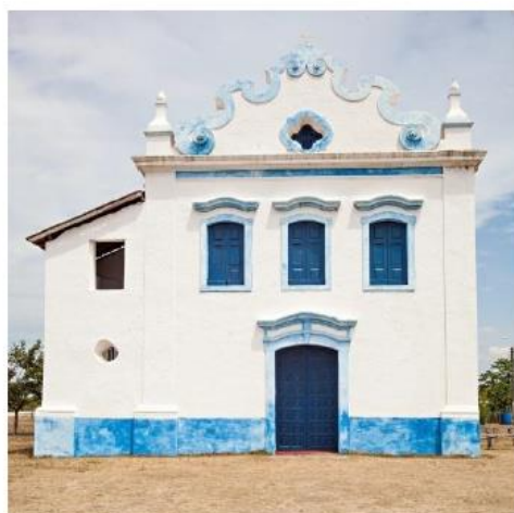
Figura 9 – Parte externa da Igreja de Nossa Senhora das Neves
