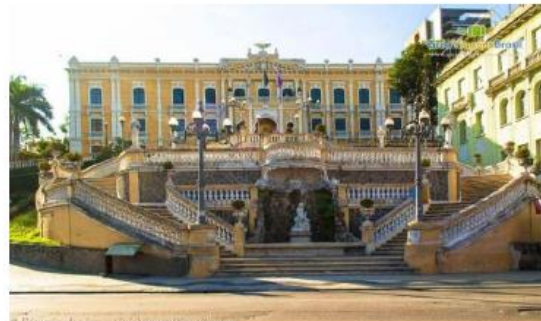
Figura 8 – Fachada do Palácio Anchieta, 2019
