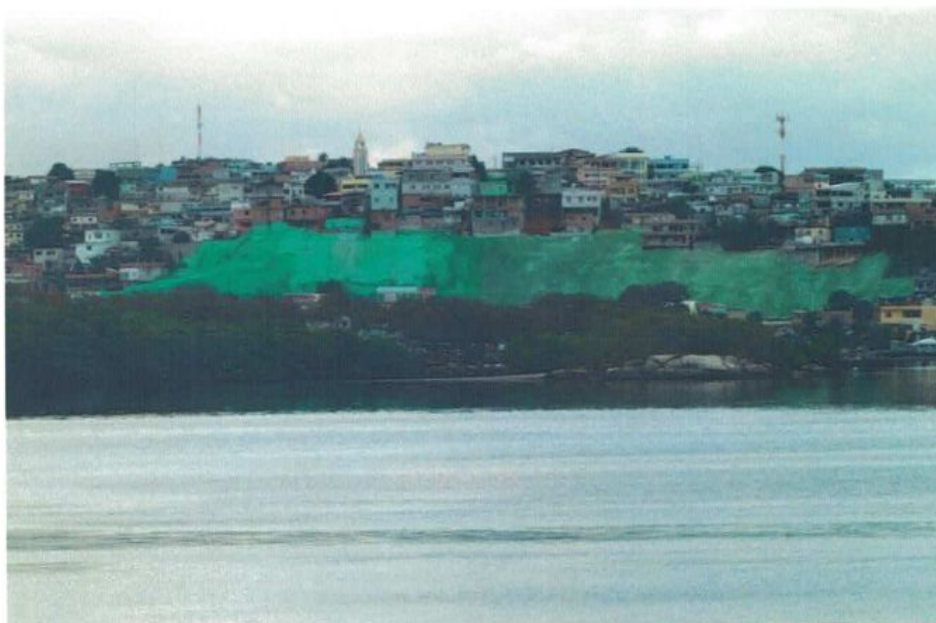
Figura 16 – Área de risco estabilizada com a geomanta
