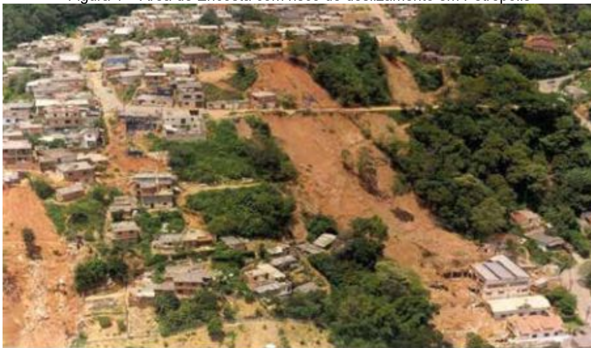
Figura 1 – Área de Encosta com risco de deslizamento em Petrópolis
