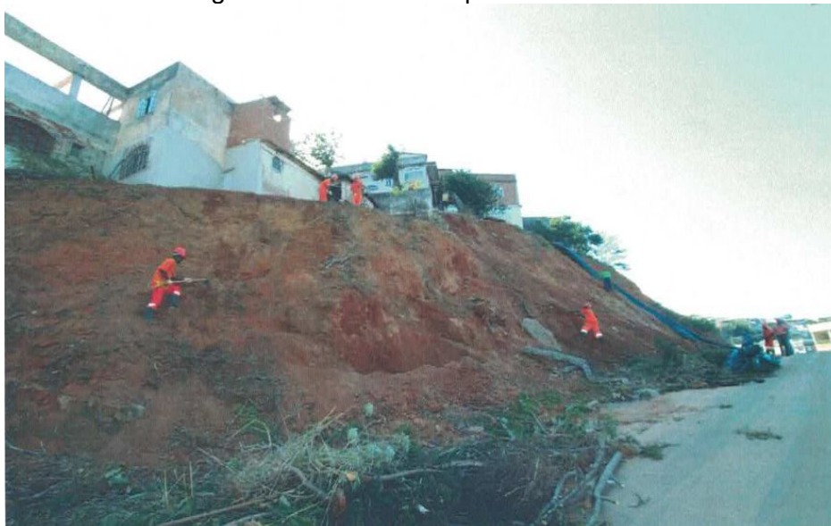
Figura 15 – Fase de limpeza da encosta
