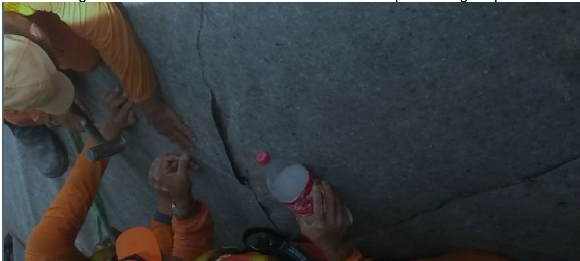
Figura 7- Emenda sendo realizada com adesivo químico e grampos.
