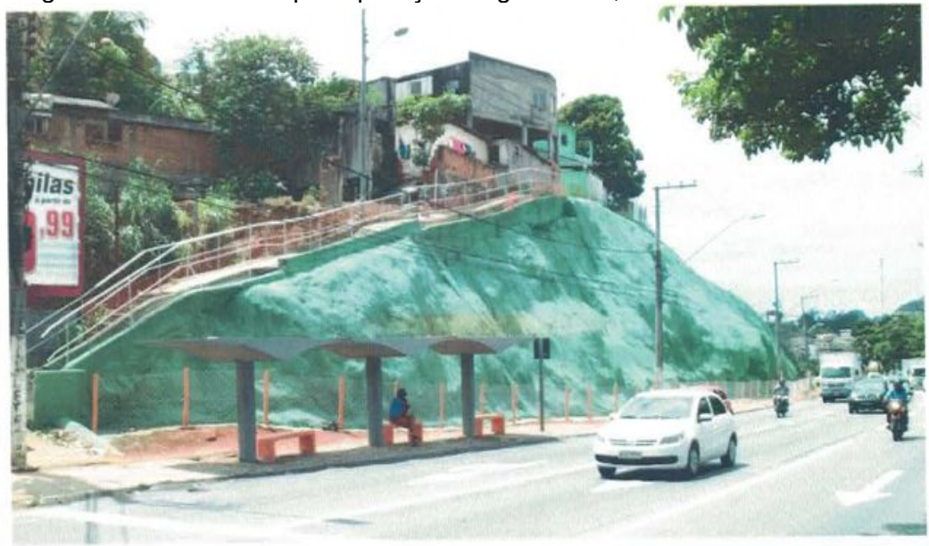
Figura 20 - Resultado após aplicação da geomanta, com terreno estabilizado
