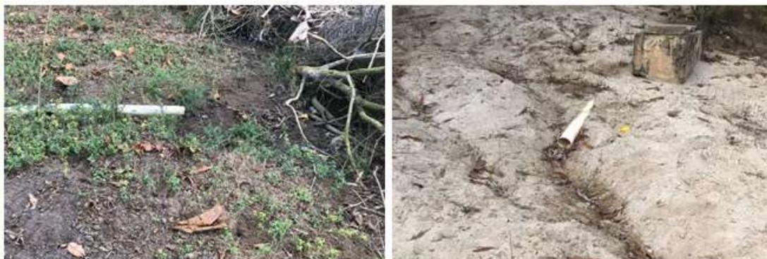
Figura 7: Esgoto de cozinha disposto sobre o solo
