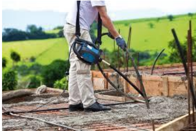
Figura 18 - Colaborador adensando o concreto mecanicamente
