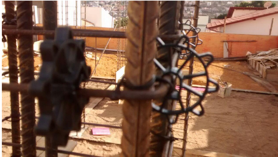
Figura 4 - Utilização de espaçadores para proteção da armadura
