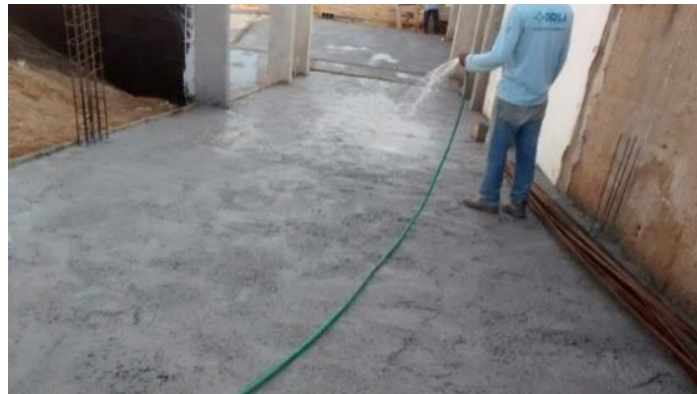
Figura 19 - Colaborador promovendo a hidratação do concreto
