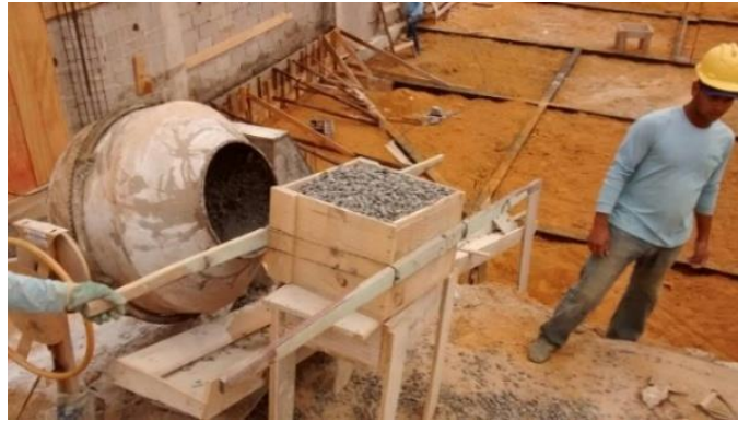
Figura 17 - Sequência recomendada de colocação de materiais
