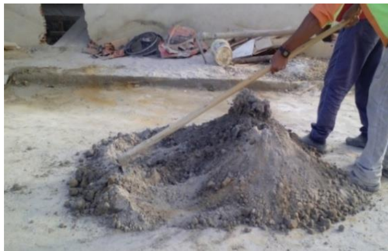
Figura 15 - Produção manual do concreto
