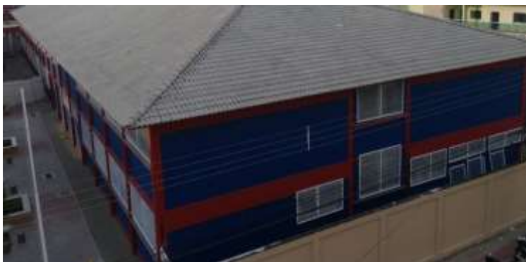
Foto 5 – Novo prédio da escola visto de outro ângulo. Fonte: https://www.facebook.com/escolabartouvinocosta/photos
