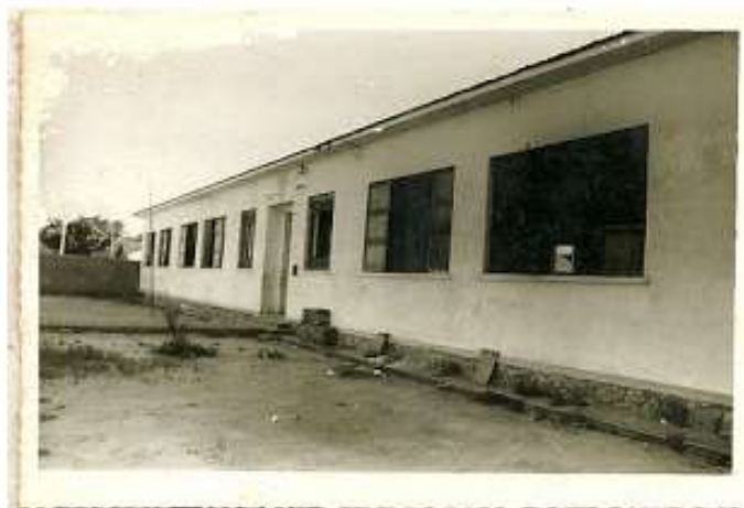
Foto 3: Fachada da escola
