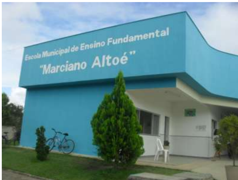
FOTO 1: Escola Municipal de Ensino Fundamental Marciano Altoé.
