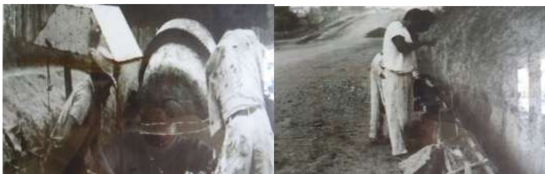
Fotografia 15: Operários trabalhando a fase final do Mercado Municipal. Fonte: NARDOTO 32 (1997)
