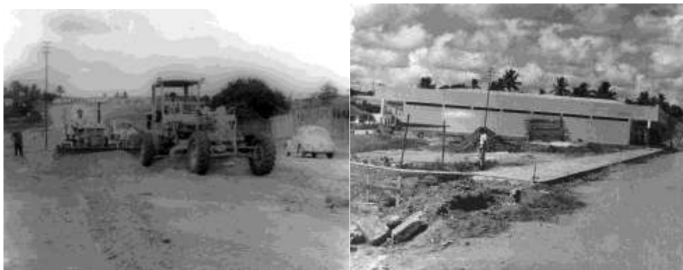
Fotografia 8: Ampliação da Av. Jones dos Santos Neves. Fonte: NARDOTO 27 (1997)
