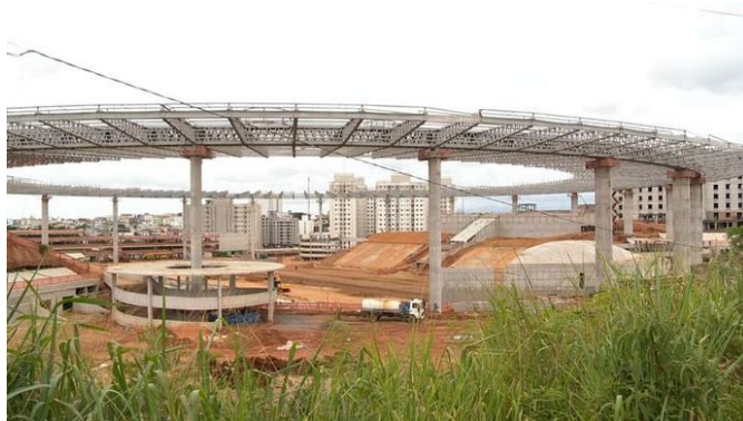
Figura 12: Máquinas trabalhando no novo Kleber Andrade, com administração do governo do Estado do Espírito Santo. Foto: Arquivo pessoal, 2014.
