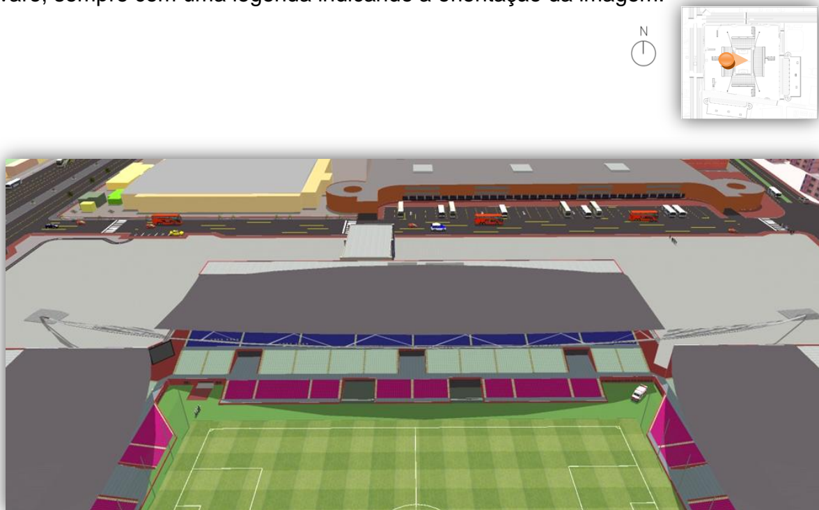
Figura 73: Arquibancada leste com distribuição dos locais dos veículos emergenciais e ao fundo estacionamento.
