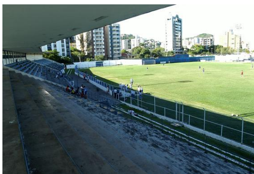
Figura 14: Inaugurado em 1967. O estádio Salvador Venâncio da Costa recebeu o nome do presidente do clube, um dos principais responsáveis pela construção do estádio. Fonte: site oficial do Vitória FC: < http://www.vitoriafc.com.br >. Acesso em: nov. 2013.
