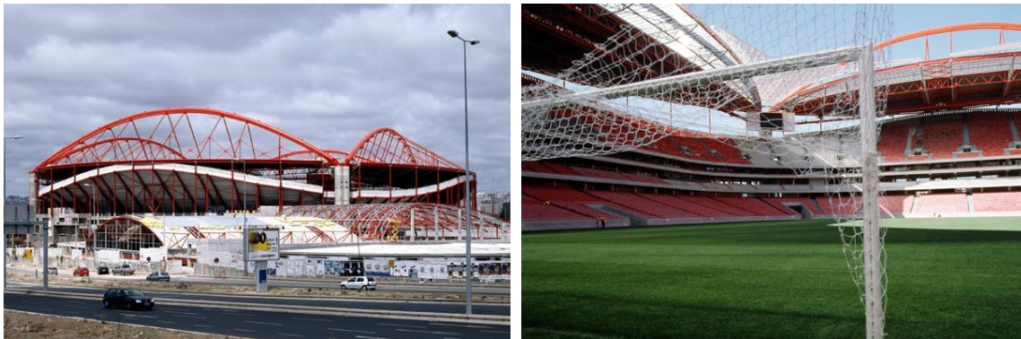
Figuras 81 e 82: Estádio da Luz – Estádio Sport Lisboa e Benfica, em Lisboa Portugal. Fonte: http://www.fussballtempel.net/uefa/POR/Luz.html (acesso: janeiro 2013).
