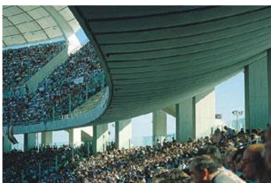
Figura 25: A sustentabilidade trabalha de forma a transmitir um conforto térmico natural ao público presente. Fonte: Cassigoli (2005).
