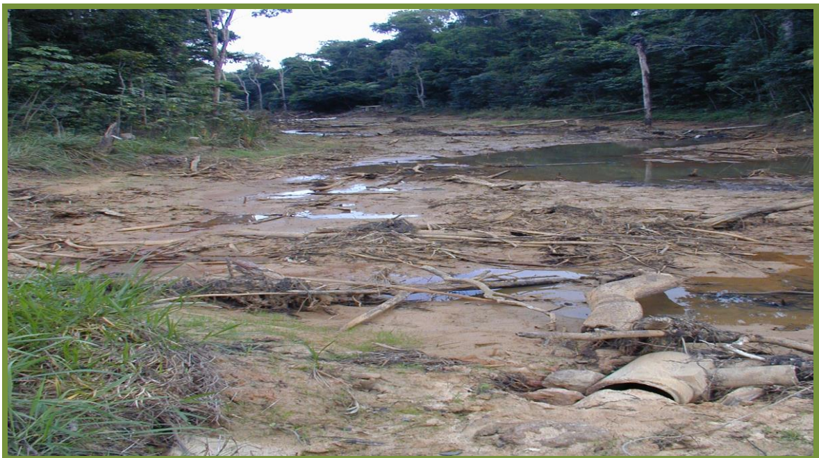
Fotografia 2: Danos ocasionados com o rompimento de barragem Fonte: Guzzo (2006, p. 32).
