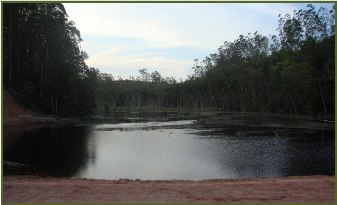
Fotografia 4: Barragem construída sob o Programa Barragem Legal no Córrego Jundiá. Fonte: Acervo pessoal.
