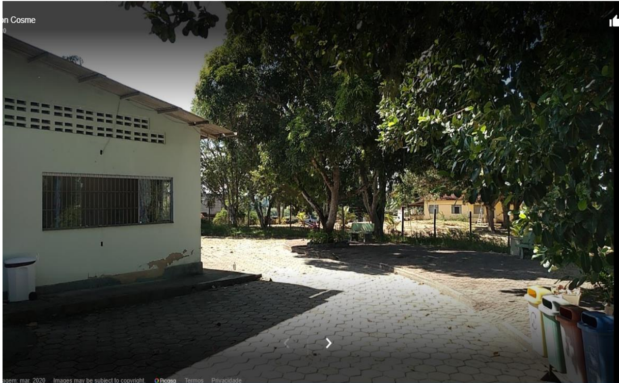
Figura 5 – Vista externa do prédio
