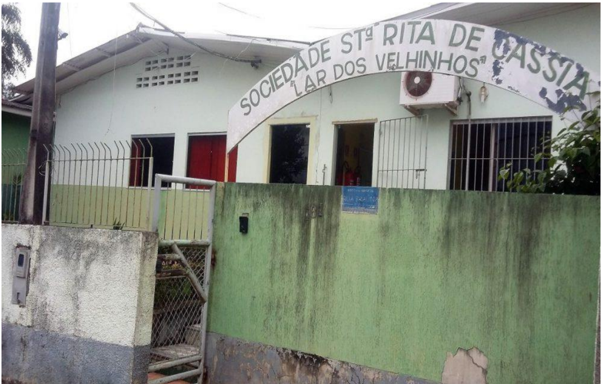
Figura 4 – Vista Parcial da Fachada
