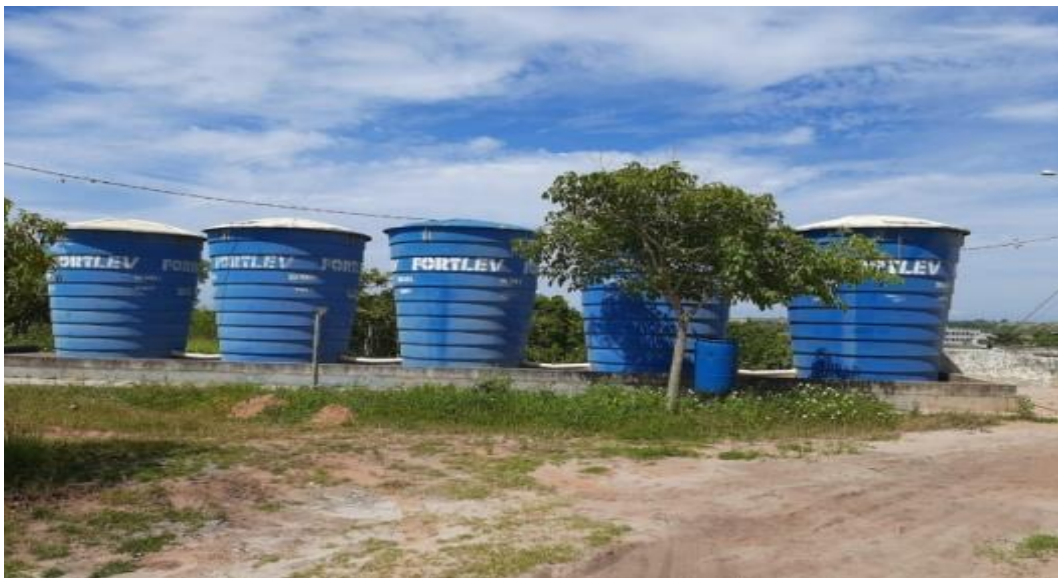
Figura 18 - Reservatórios utilizados para armazenar e redistribuir água nas comunidades de Marobá e Criador
