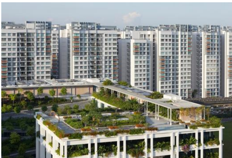
Imagem 02 - Vista dos terraços. Fonte: www.archdaily.com.br
