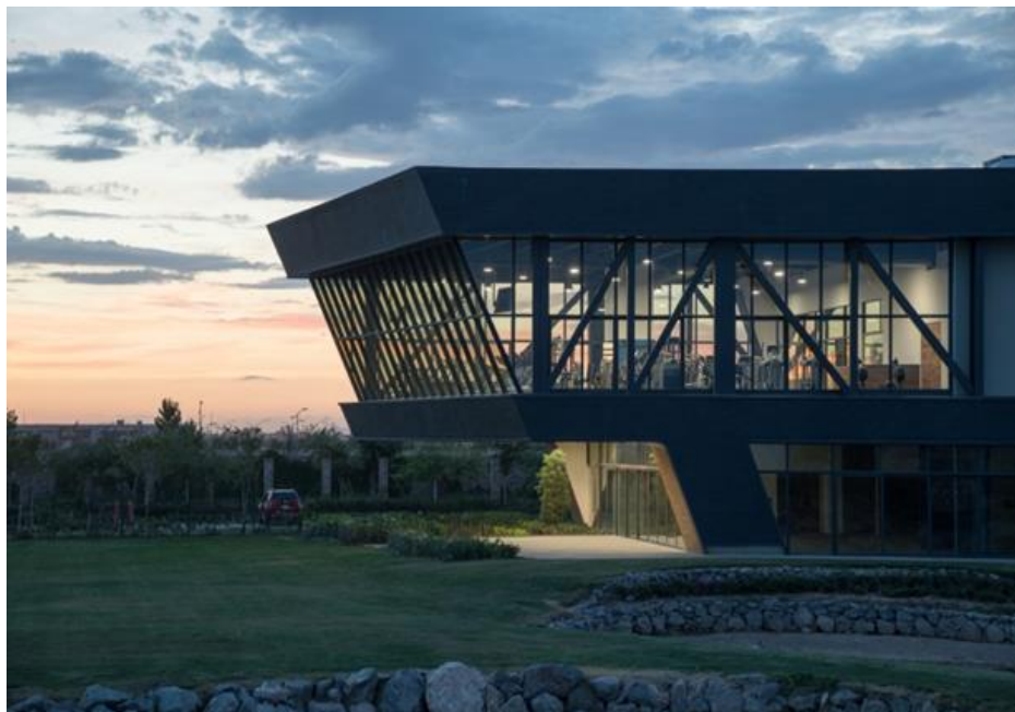
Imagem 69- Parte do segundo pavimento em balanço. Fonte: www.archdaily.com.br
