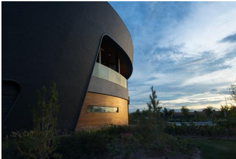
Imagem 71- Fachada Posterior. Fonte: www.archdaily.com.br
