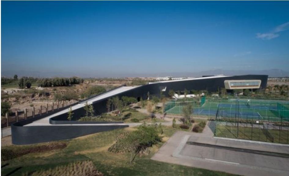
Imagem 24 - Volumetria da Edificação. Fonte: www.archdaily.com.br .
