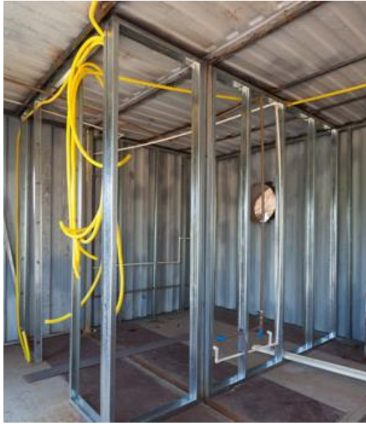
Figura 28: Drywall - Construção da “Casa D’água”
