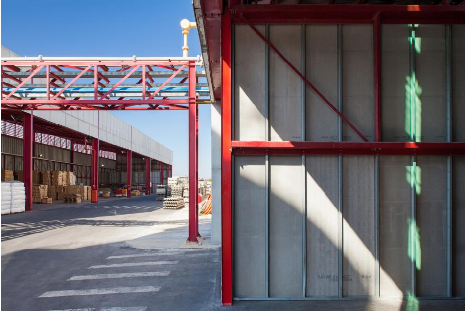
Figura 11: Parede steel frame Brasilit Saint-Gobain Seropédica
