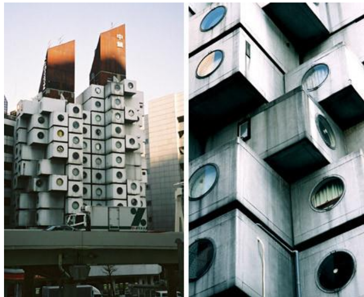
Figura 01: Fachada do edifício Nakagin Capsule Tower
