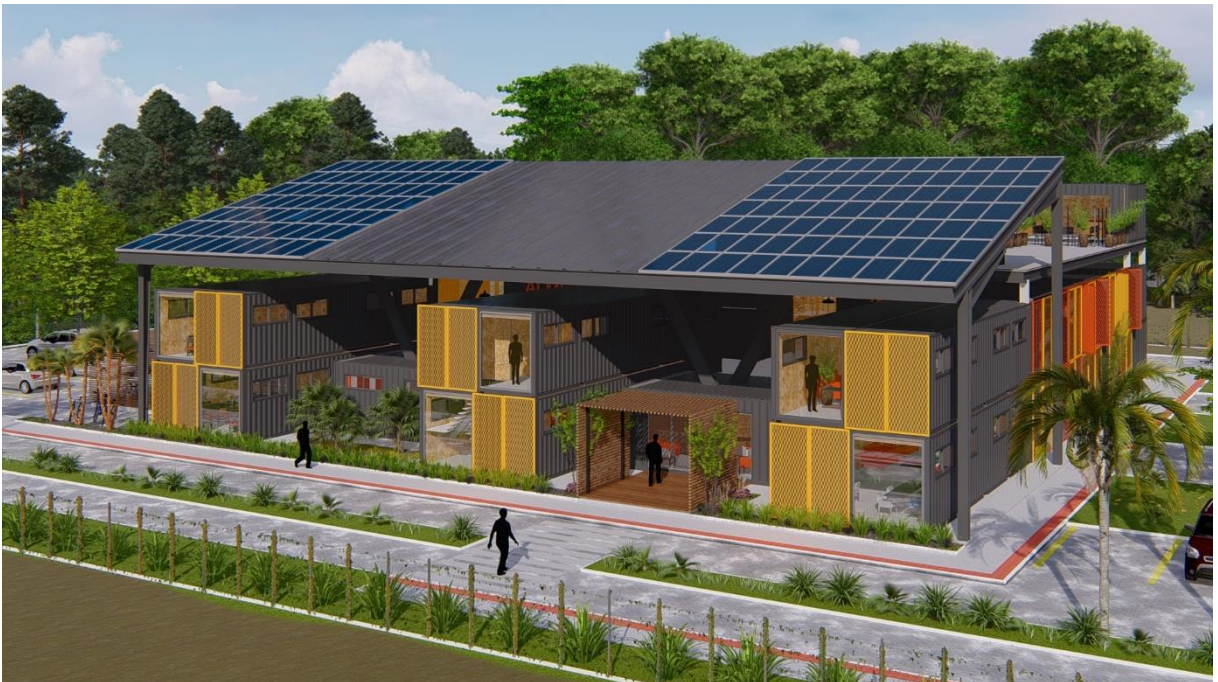
Figura 39: Perspectiva 02, fachada com painéis solares formando a cobertura.
