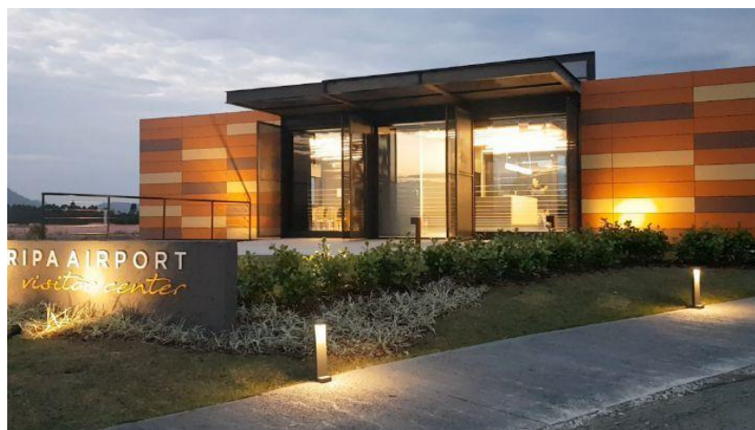
Figura 02: Fachada Floripa Aiport, em construção modular
