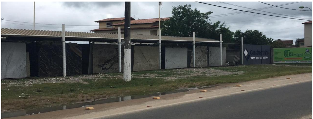
Figura 32: Rodovia Othovarino Duarte Santos, em Guriri, com um trecho sem calçadas adequadas. Fonte: arquivo pessoal. Novembro 2019.
