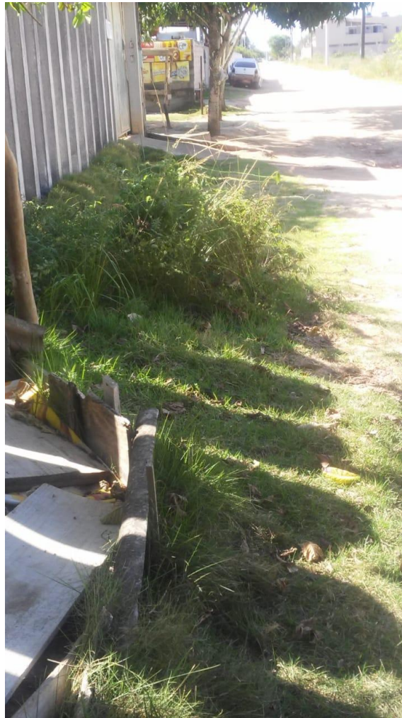
Figura 31: Guriri com ruas sem calçamento e calçadas inadequadas. Fonte: arquivo pessoal. Julho 2019.
