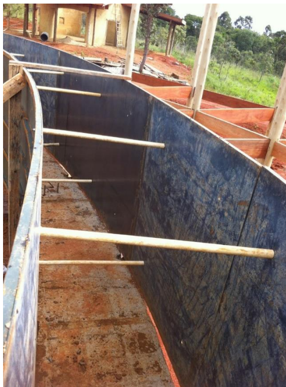
Figura 56 - Fixação feita por tirantes - http://tecnicasparaconstrucaosustentavel.blogspot.com/2015/05/como-fazer-paredes-de-taipa-de-pilao.html - Acesso em 30/10/2019
