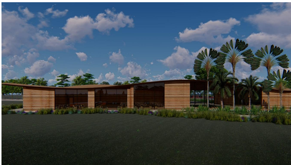
Figura 64 - Paredes de Taipa de Pilão com Fechamento em Montantes Metálicos e Vidro
