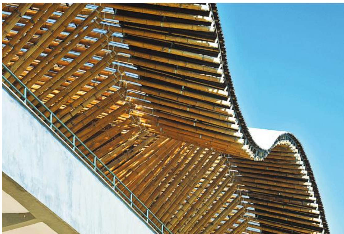
Figura 59 - Centro de cultura max feffer – Cobertura sustentável de bambu - https://www.arcoweb.com.br/finestra/tecnologia/selo-leed-centro-cultural-max-feffer - Acesso em 31/10/2019
