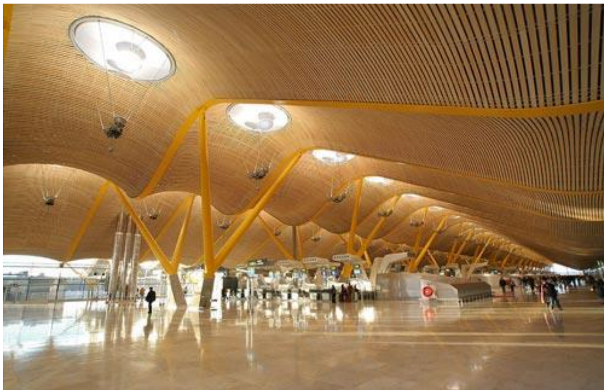
Figura 60 - Forro com tecido de bambu do aeroporto Baraja de Madri, Espanha - Foto Hoepers (2007) – Acesso 01/11/2019
