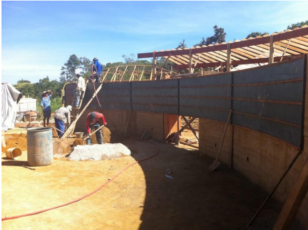
Figura 58 - Utilização e Formas para modelagem da parede - http://tecnicasparaconstrucaosustentavel.blogspot.com/2015/05/como-fazer-paredes-de-taipa-de-pilao.html - Acesso em 30/10/2019
