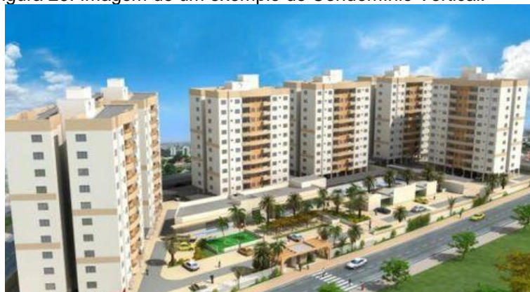
Figura 26: Imagem de um exemplo de Condomínio Vertical.
