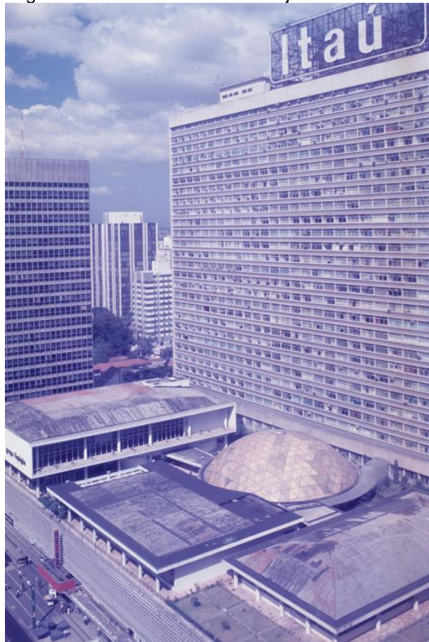
Figura 27: Imagem do Condomínio Misto Conjunto Nacional em São Paulo.
