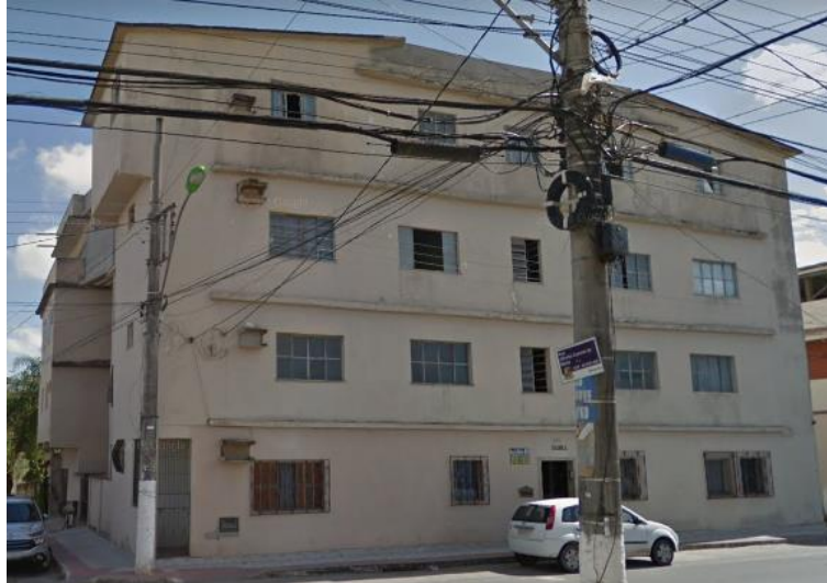
Figura 25: Imagem do Edifício Carla na cidade de São Mateus.
