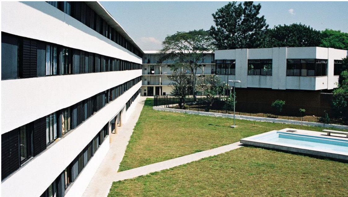
Figura 06: Vila dos idosos – Vista externa
