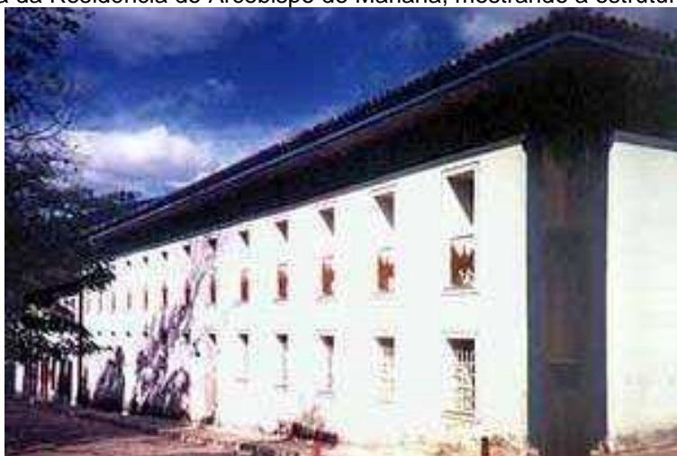
Figura 13: Fachada da Residência do Arcebispo de Mariana, mostrando a estrutura metálica
