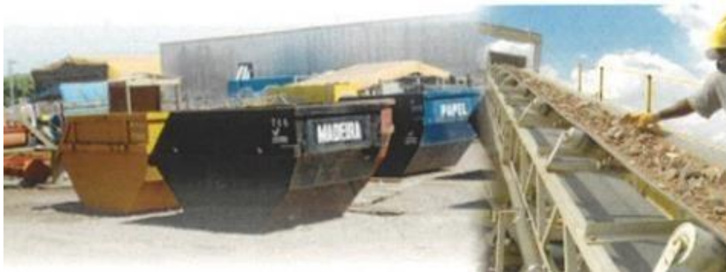
Figura 5 - Caçambas de descarte de resíduos da construção civil
