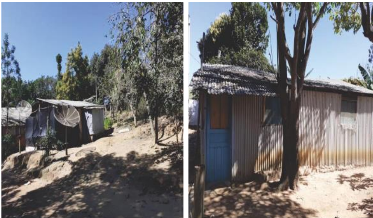
Figura 14 – Foto de uma das casas, mostrando detalhes do tipo de construção e infraestrutura existente
